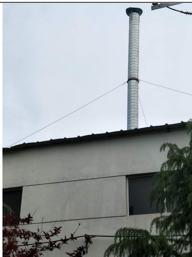
固化废气经等离子光氧设备处理后经 15 米高排气筒（P2）排放
