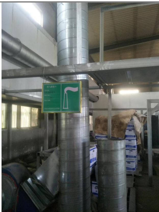
固化废气经等离子光氧设备处理后经 15 米高排气筒（P2）排放
