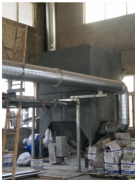
喷塑粉尘自带滤芯回收+布袋除尘器处理后，再经 15 米高排气筒(P1)排放
