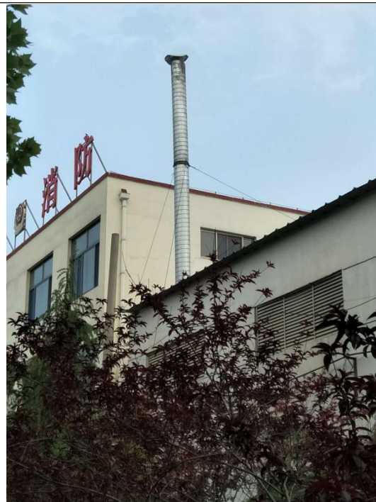
喷塑粉尘自带滤芯回收+布袋除尘器处理后，再经 15 米高排气筒(P1)排放
